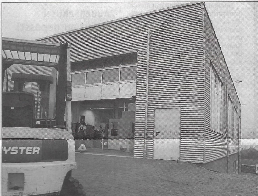
Nur ein halbes Jahr dauerten die Bauarbeiten für den Neubau in Grafenberg.
